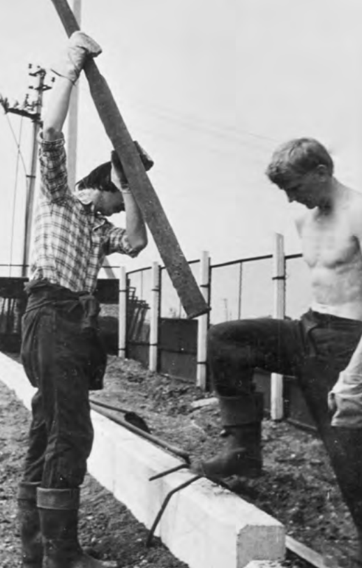
Общестроительные работы у студентов ПГС. Башкирия, п. Шакша, 1978 г.
