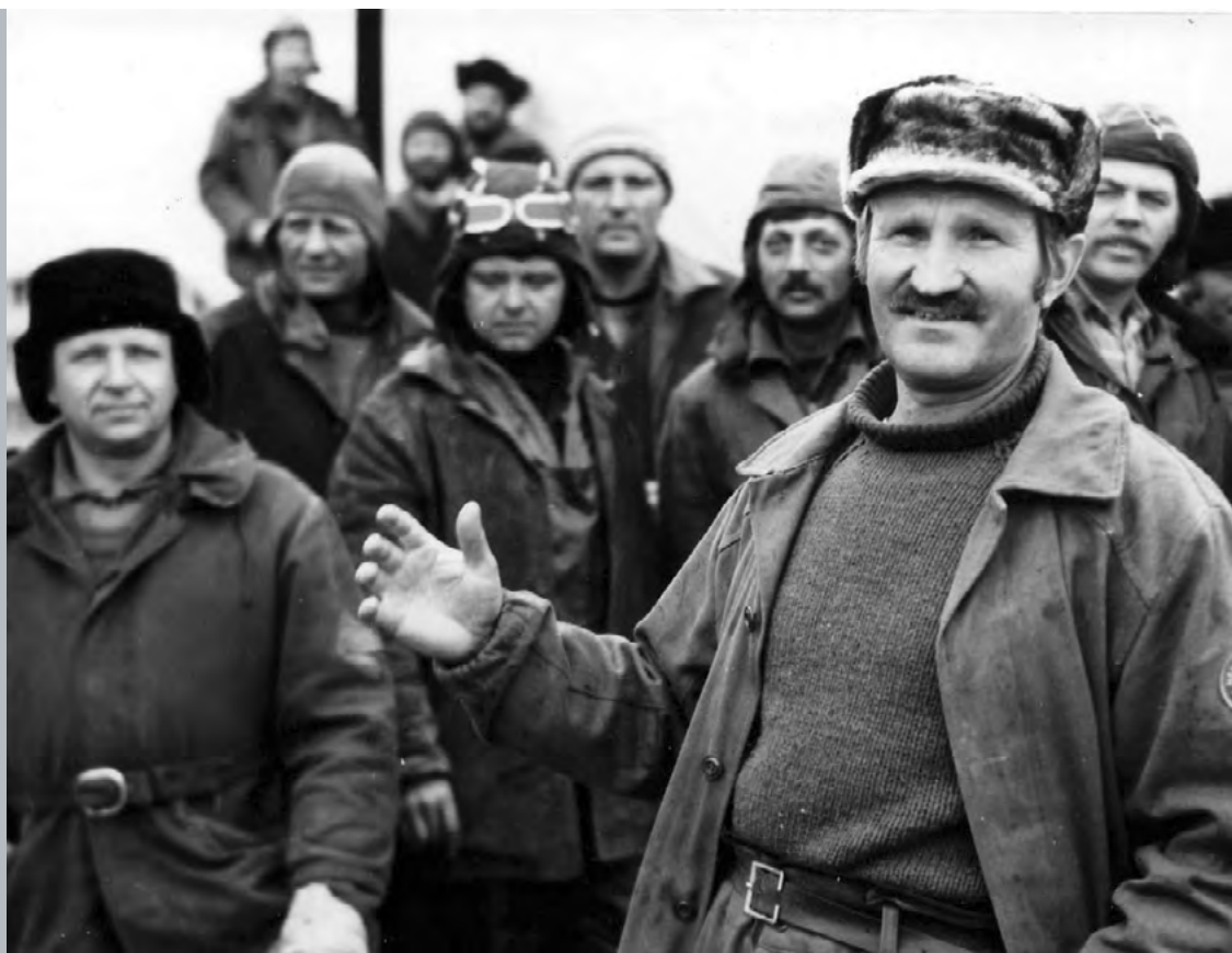
1987 г. Полуостров Ямал. На Харасавэе работают только те, кто может вынести все трудности Заполярья. Бригада вышкомонтажников из Экспедиции глубокого бурения. В центре – начальник участка Приймак
