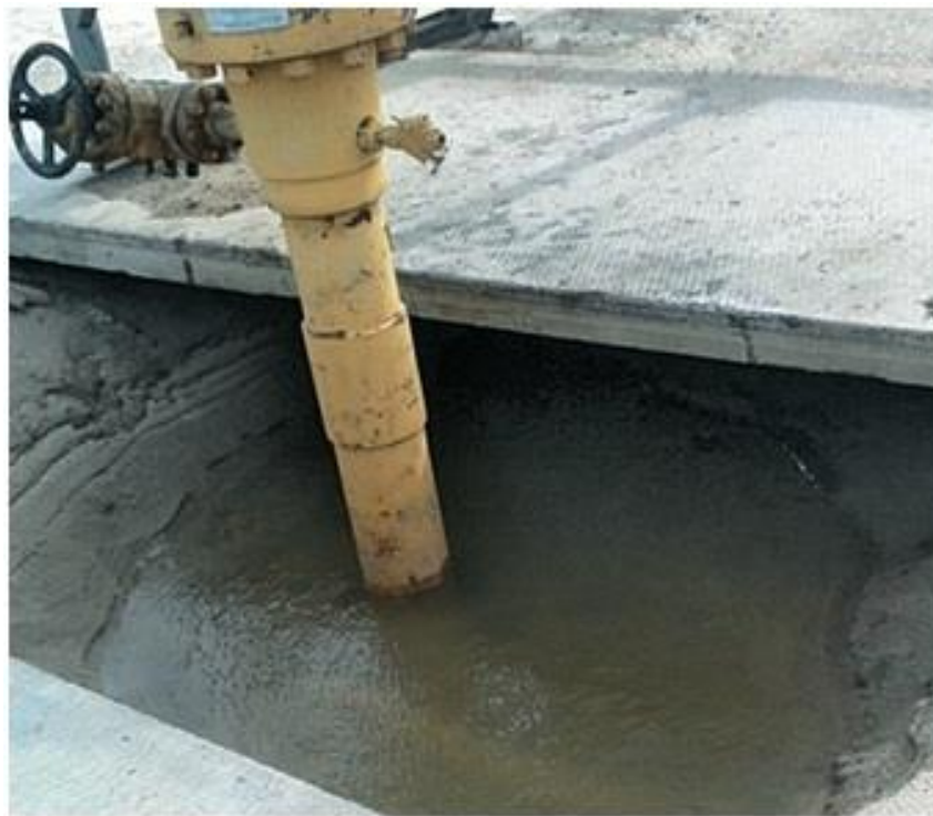
Рисунок 1.1 – Осложнение в виде воронки на Ямбургском газоконденсатном месторождении [37]
