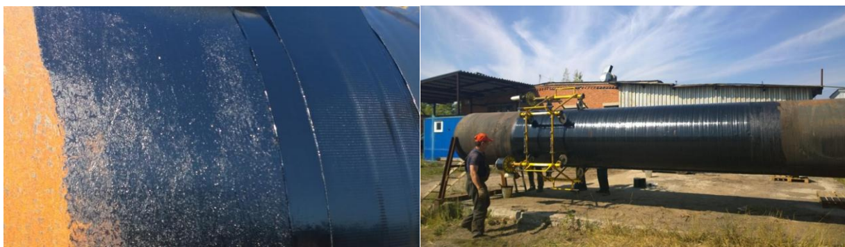
Рисунок 1.6 – Нанесение защитного покрытия с ингибиторами КРН
