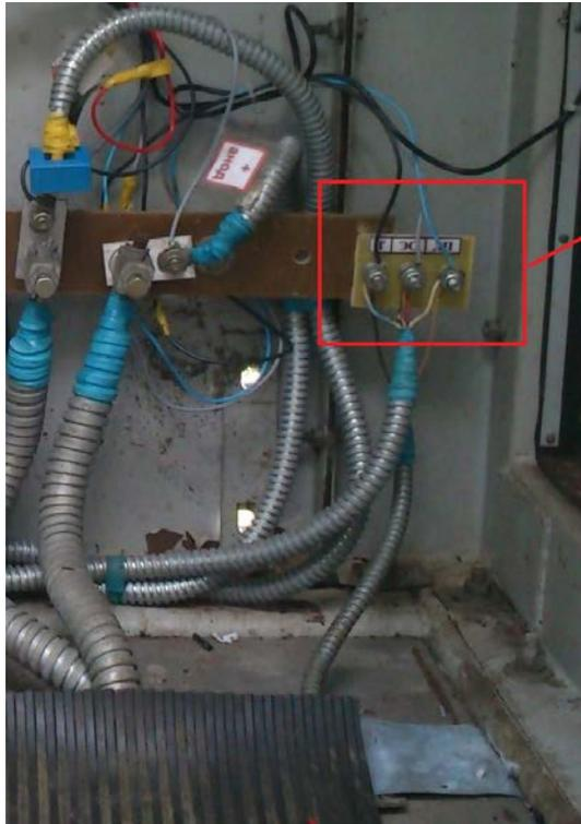
Клеммная панель внутри блок-бокса СКЗ
