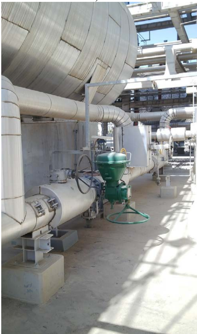
Рисунок 4.15 - Оборудование экспериментального стенда на УПН «Мишриф» а – точка подключения промывной воды с водосчетчиком; б – место подключения экспериментального смесителя; в – действующее оборудование блока обессоливания ТЛ-7 УПН (обессоливатель со штатным смесителем); г – экспериментальные смесители и водосчетчик с коннекторами
