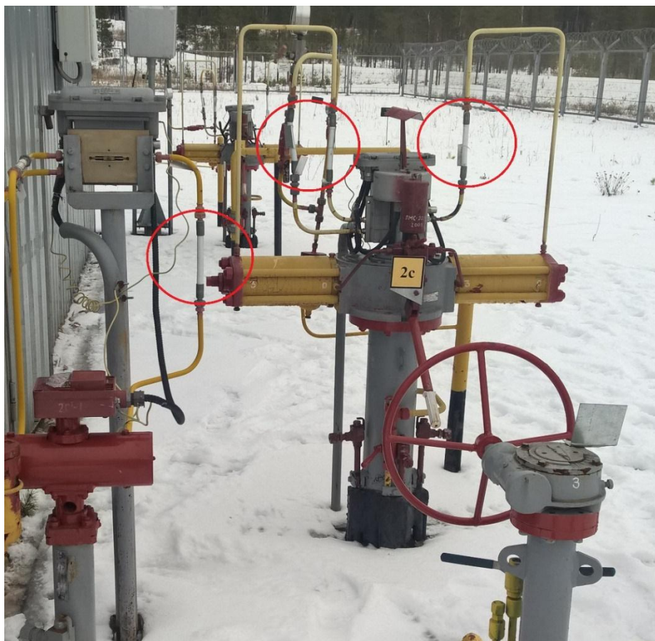
Рисунок 1.7 – Пример установки электроизолирующих вставок на трубках отбора импульсного газа блока управления запорной арматурой
