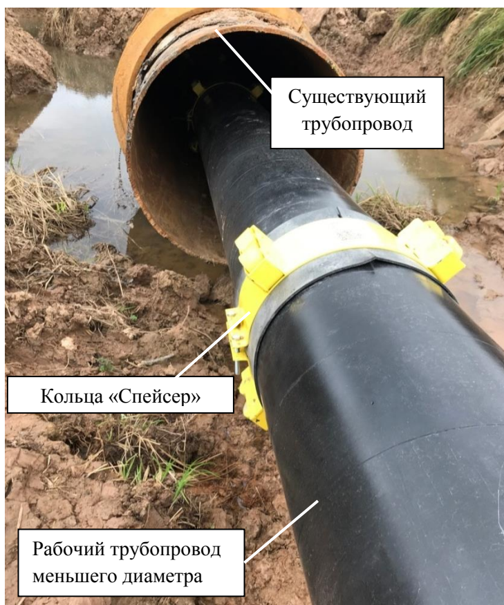
Рисунок 5.1 – Конструкция перехода «труба в трубе»
