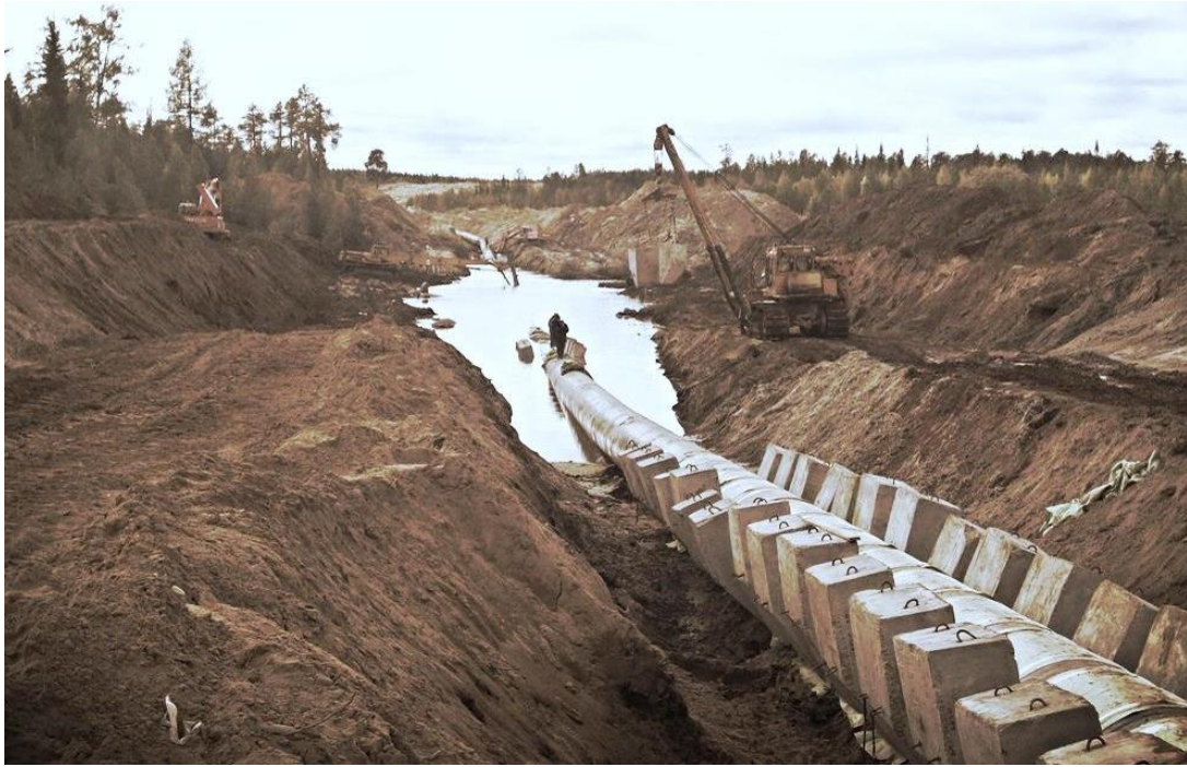
Рисунок 1.3 –Забалластированный трубопровод, уложенный в траншею
