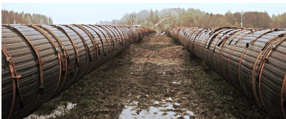
Рисунок 1.2 –Подготовленная к укладке в подводную траншею плеть трубопровода
