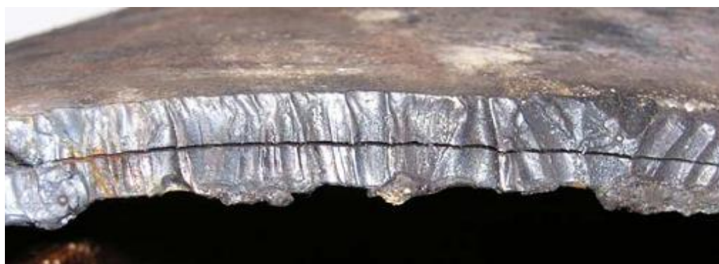
Рисунок 2.24 – Внешний вид расслоения стенки трубопровода
