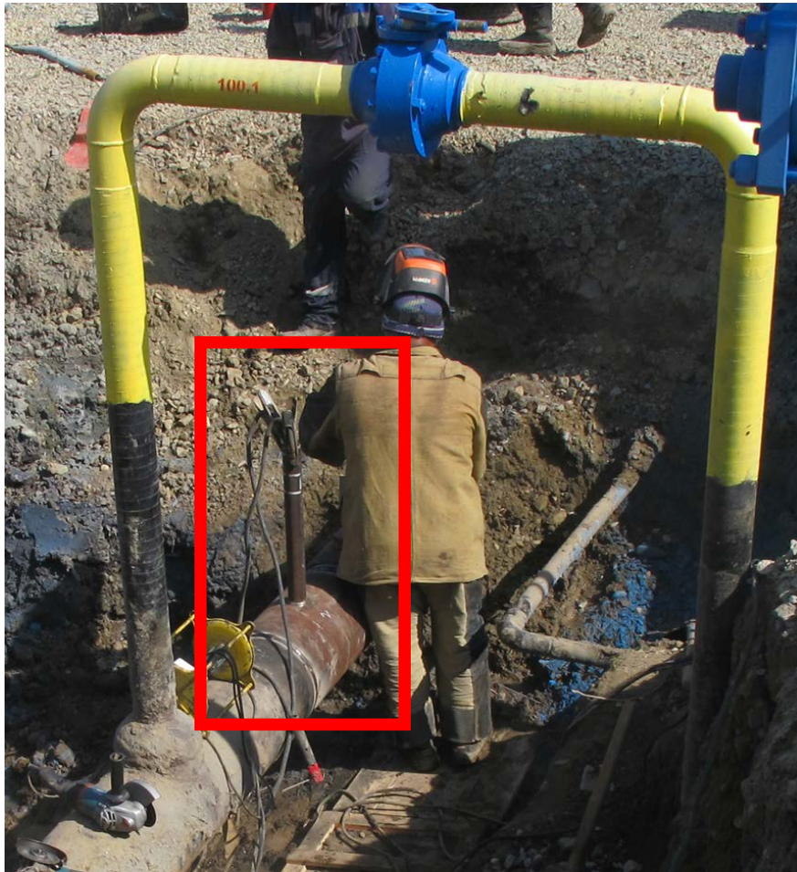
Рисунок 4.13. Монтаж нового соединения (типа «прямая врезка») стояка ОИГ с основной линией байпаса
