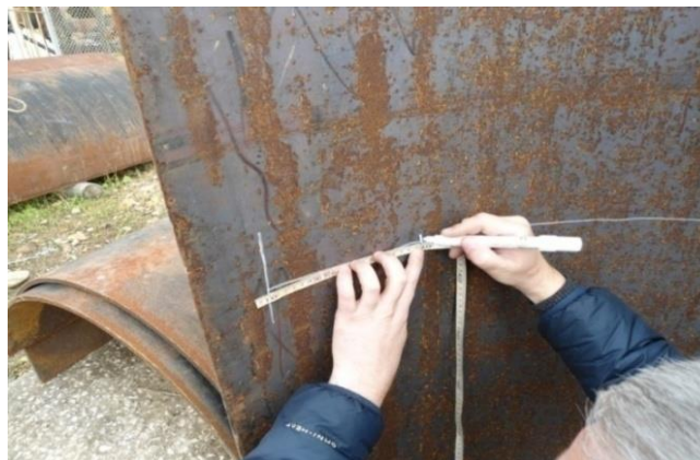
Рисунок 2.11 – Разметка внутренней поверхности полумуфт
