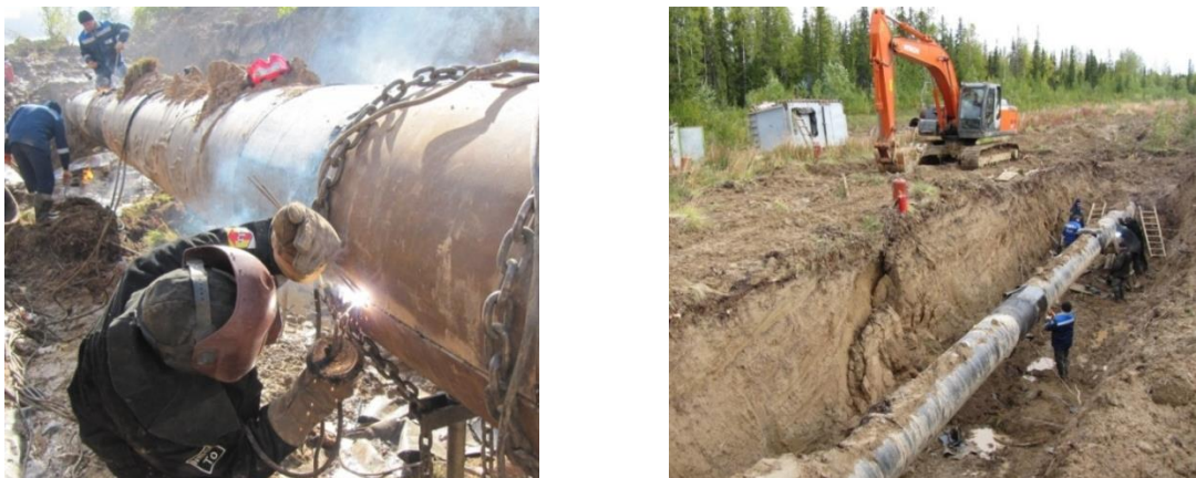
Рисунок 5.25 – Рабочие моменты ремонта конденсатопровода «Вуктыл СГПЗ» 2 нитка
