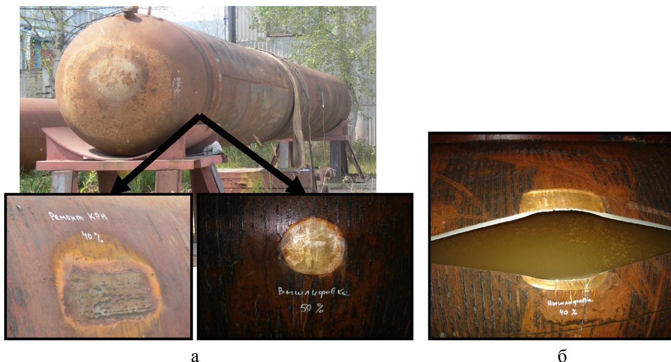
Рисунок 19 – Трубная плеть с отремонтированными дефектами а – ремонт дефектов методом заварки и контролируемой шлифовки; б – очаг разрушения плети
