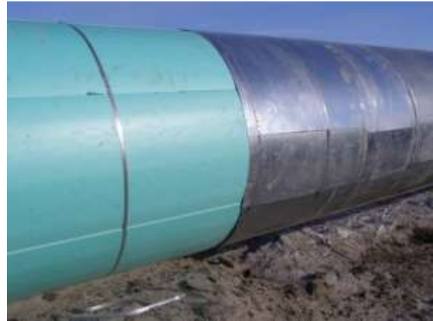
Рисунок 2.18 – Термоизоляция МГ сегментами «Пеноплекс» толщиной 100 мм (а) и защита теплоизоляционного слоя стальным оцинкованным листом (б)
