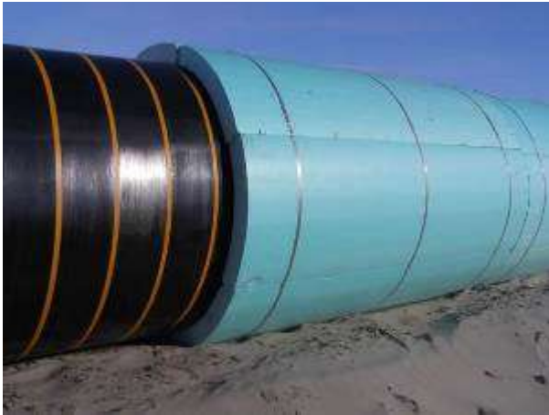
Рисунок 2.18 – Термоизоляция МГ сегментами «Пеноплекс» толщиной 100 мм (а) и защита теплоизоляционного слоя стальным оцинкованным листом (б)
