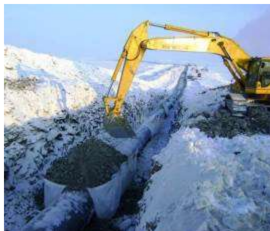
Рисунок 2.15 – Конструкция грунтозадерживающих барьеров из КП-Р-1.8
