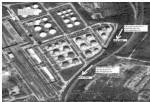
Рисунок 2 – Результаты сканирования противопожарного водопровода В2-6 ООО «ЛУКОЙЛ-УНП».
