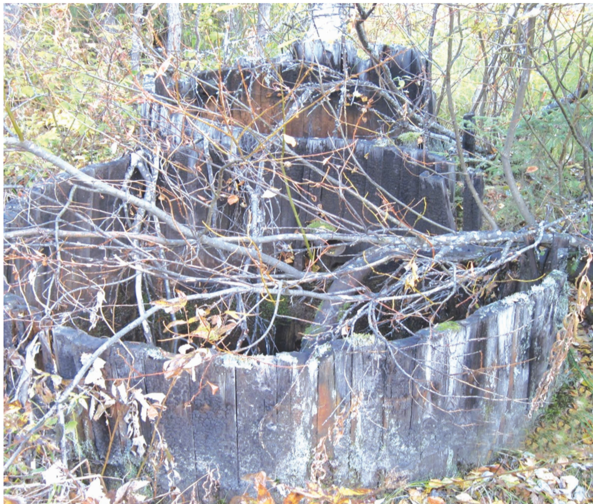
Деревянные бочки для сбора радиоактивной воды на заводе № 12 поселка Водный. Фото автора
