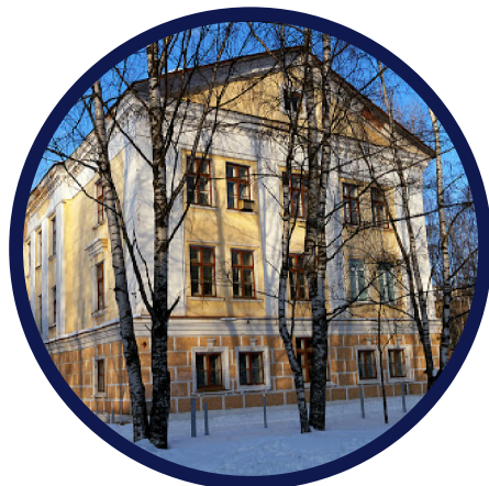
Корпус «Д» ул. Первомайская, 9
